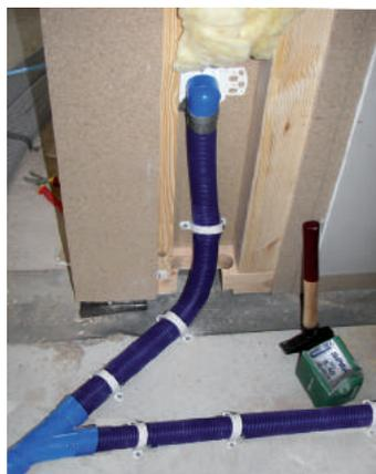
Der Unterbau wird in die einseitig offene Ständerwand eingebaut, das Flexrohr am Boden und Wand fixiert. Unmittelbar nach jeder Muffe oder Abzweig das Flex-Rohr mit einer Rohschelle sichern.
